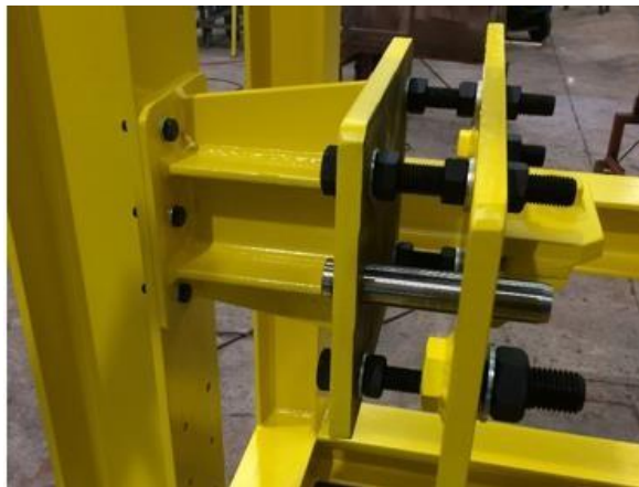
Joints boulonnés Pré-assemblage
